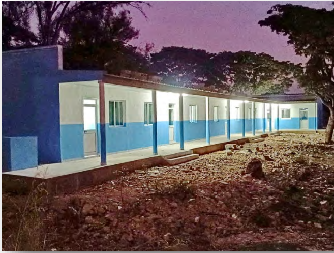
Neubau des Berufsausbildungszentrums in Chipindo-Sangueve. Dank der autonomen Stromversorgung mit Generator ist auch eine Nutzung in den Abendstunden möglich.
