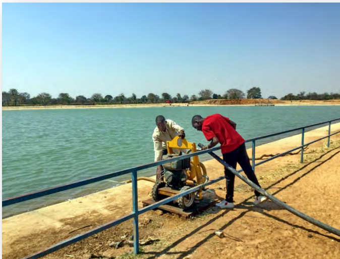
Pumpenwarte einer Bewässerungskoooperative am Cafu-Kanal nehmen eine Motorpumpe in Betrieb, Mai 2023
